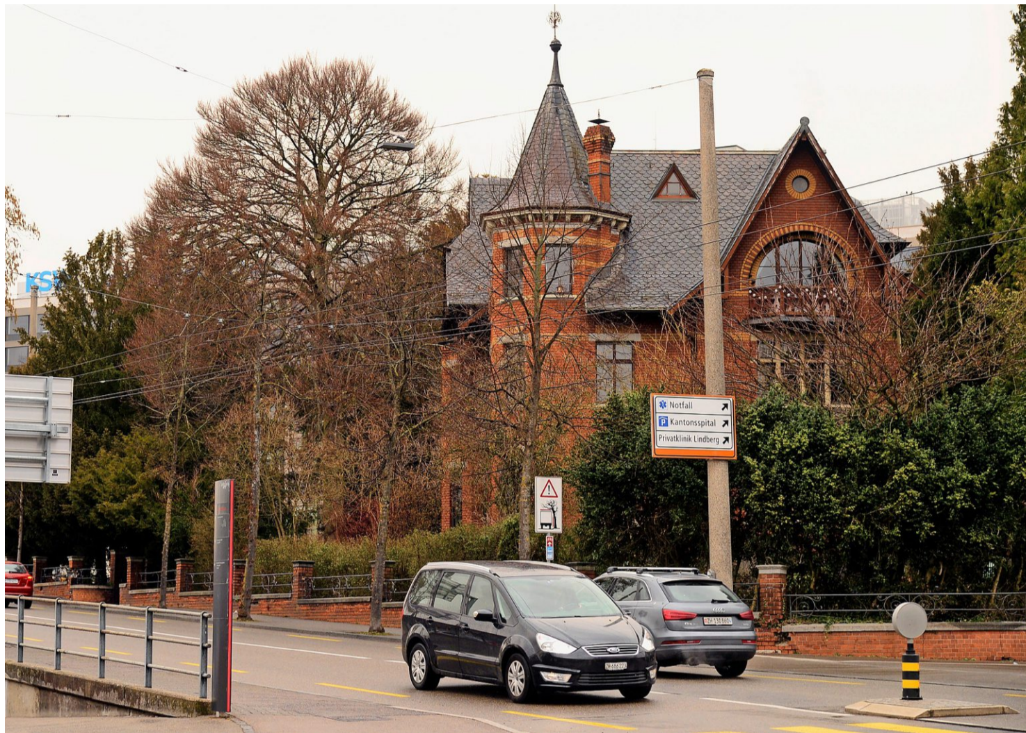
Dem Ziel einen Schritt näher: In dieser Backstein-Villa soll sich ab Spätsommer 2023 das Geburtshaus Winterthur befinden. Foto: Marc Dahinden
